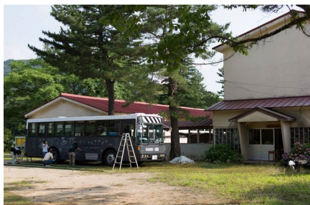
11日のフィールドワークで訪れる予定の旧阿東町立亀山小学校
